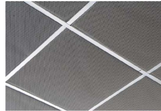
Готовое изделие представляет собой металлическую сетку с ячейками ромбовидной, круглой, квадратной или другой формы. Благодаря использованию листового металла сетка имеет цельную структуру без наличия сварных швов. Её полотно состоит из ячеек, расположенных в одной плоскости с естественной трёхмерной структурой. Даже в случае нарушения целостности одного из элементов полотна, вся сетка не распускается.
